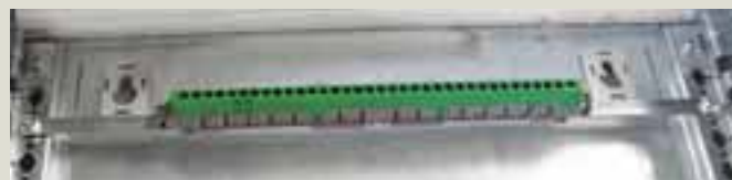
Крепление плоской рейки непосредственно к монтажным стойкам.
